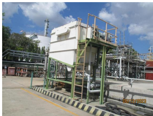
รูปที่ 3.2-10 DOX Separator
