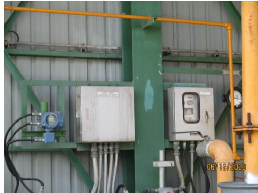
รูปที่ 3.2-65 Chlorine Gas Detector
