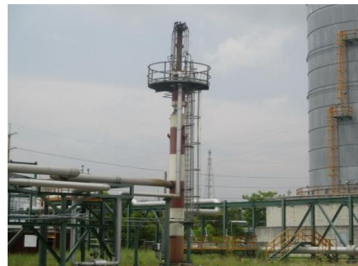
รูปที่ 3.2-4 Low Pressure Flare
