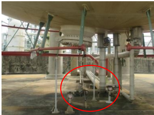
รูปที่ 3.2-55 Hydrocarbon Gas Detector
