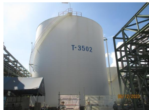
รูปที่ 3.2-20 Condensate Storage Tank
